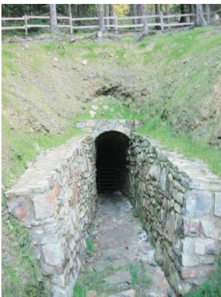
Der Eingang zum Stollen in der Dredenbach im Buchhellertal ist eins der Relikte aus der Bergbauzeit, die gesichert werden konnten.
